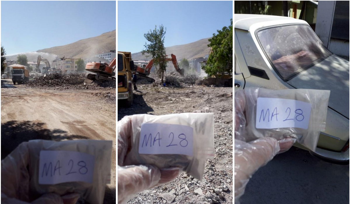
Şekil 9.b-c-d. Elbistan kent merkezinde yıkım/hafriyat çalışması süren ve asbest tespit edilen nokta; sahadan görüntüler.
