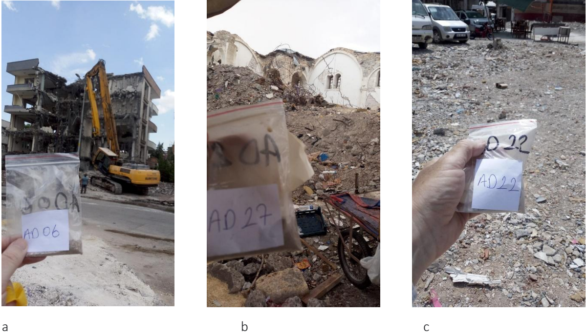
Şekil 11. Farklı özelliklerde noktalardan örneklemeler- a) Yıkımın örnekleme gününde devam ettiği bir nokta b) Yıkımın daha önce gerçekleştiği ancak hafriyatın kaldırılmadığı bir nokta c) Yıkımın daha önce gerçekleştiği ve hafriyatın kaldırıldığı bir nokta
